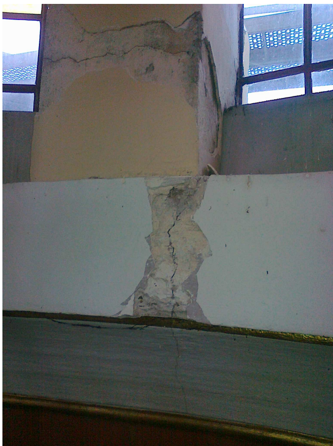
Fot.2. Zarysowania na wewnętrznej części kolumny oraz belce obwodowej
