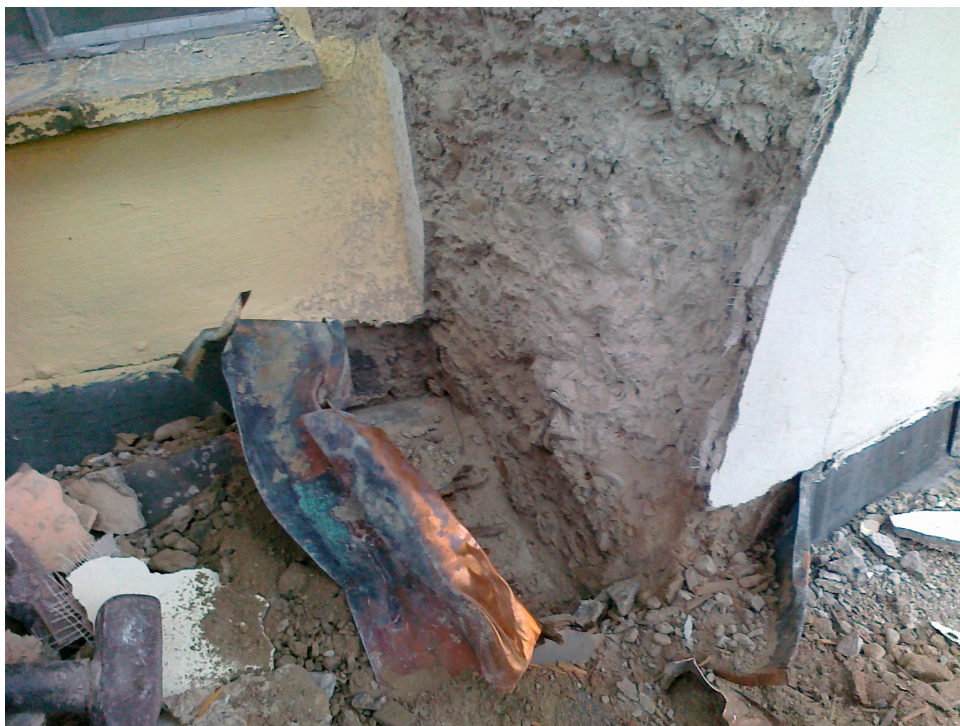
Fot.1. Zniszczona struktura betonu podstawy części zewnętrznej kolumny
